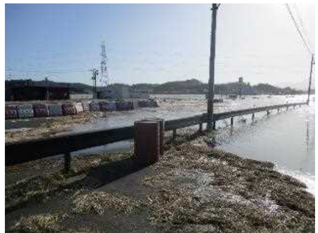
国道 4 号線(大崎市三本木地区)
