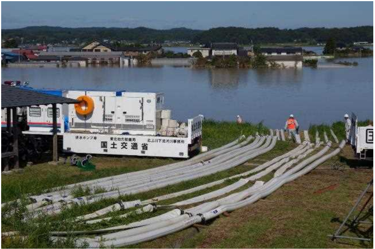
※国土交通省排水ポンプ車による大崎市鹿島台大迫地区排水作業
