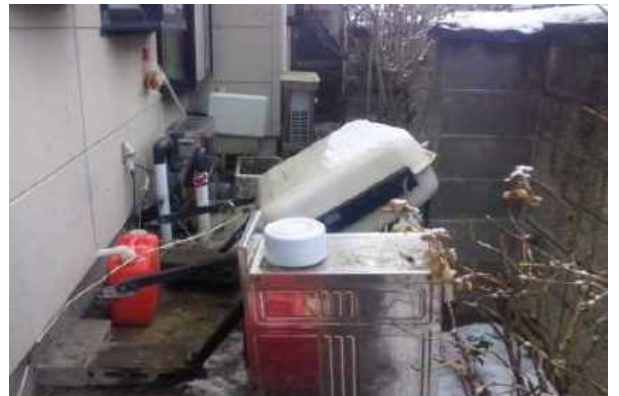
「転倒したホームタンク h23.3.11」
